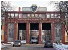
Завод ГАЗ, Нижний Новгород
