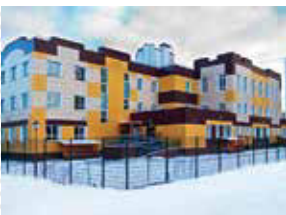
ДОУ Шувалово-Озерки, г. Санкт-Петербург
