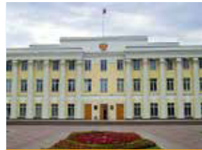
Здание Администрации, г. Дзержинск
